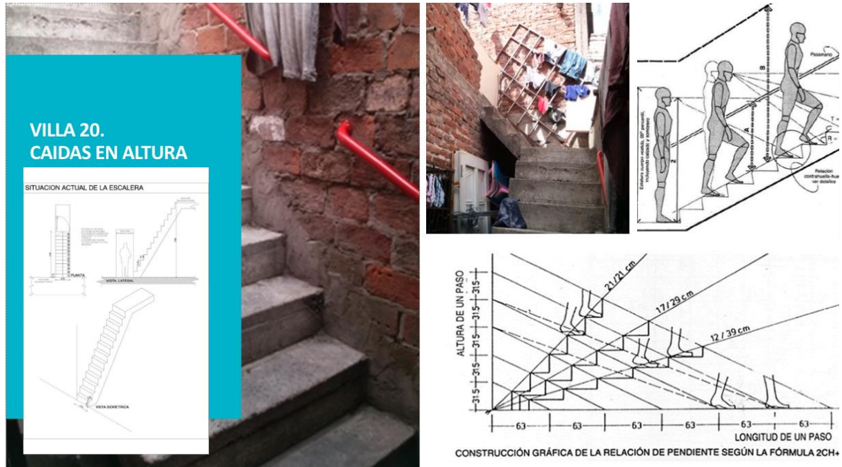
Figura 4. Relevamiento físico del estado de las escaleras de las viviendas visitadas.
